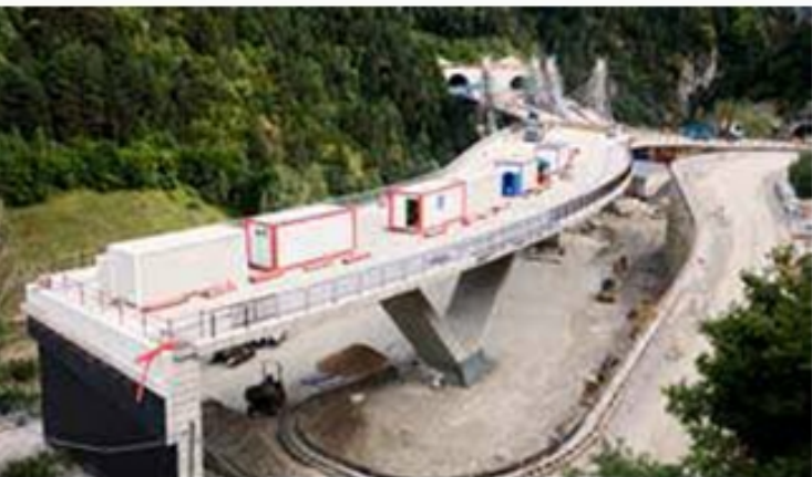
アンドラ公国で建設中の高架橋とトンネル
